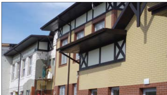
Szkoła w Straszynie, budowa idzie na przód
