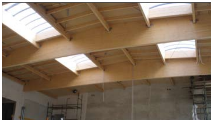
Hala gimnastyczna jeszcze w budowie
